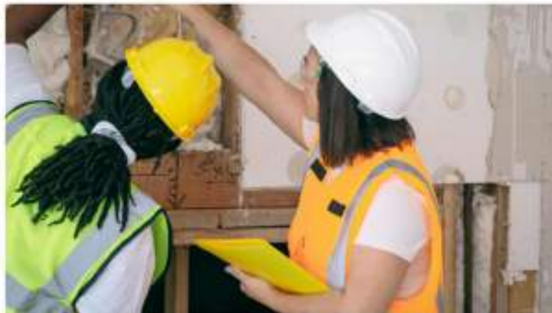
Anticiper les normes PEB lors de votre chantier - Du Peleux
